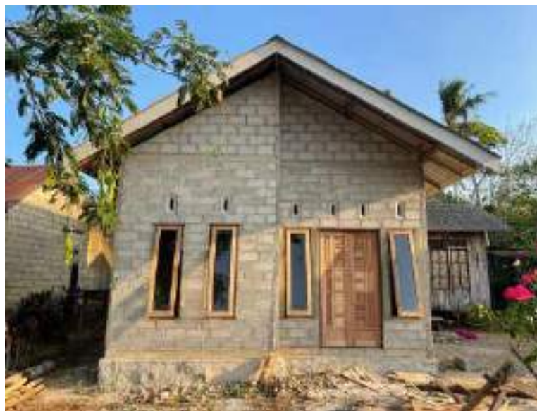
Gambar Setelah direhab
